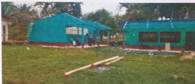
Foto 2: Se observa que los señores padres de familia participan en equipo para el cambio de costaneras.
